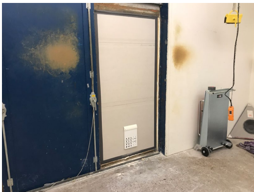
Bild 13 – Uteluftsdon YSO 23035020S monterat i provväggen.
