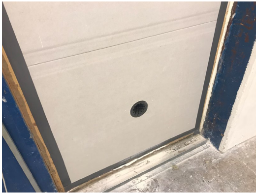
Bild 11 – Genomföringsröret monterat i provväggen.
