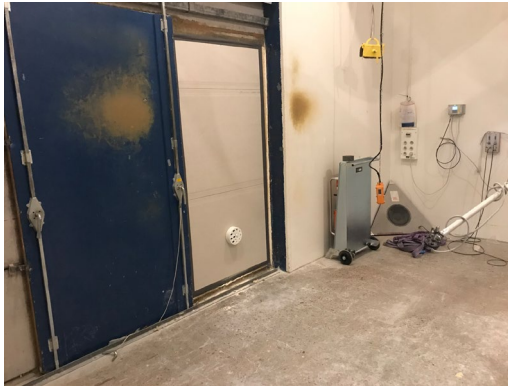
Bild 15 – Uteluftsdon YSO Ø16012 monterat i provväggen.
